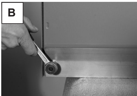
Avmontera nedre montagelisten
