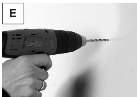
Borra i markeringarna vid användning av ex. plugg
