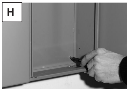
Märk ut hålen på väggen där den demonterade montagelisten satt
