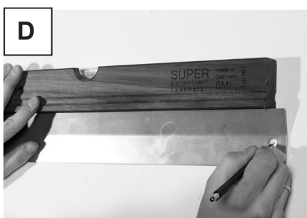
Rikta in den demonterade montagelisten i våg på väggen och märk ut hålen på väggen
